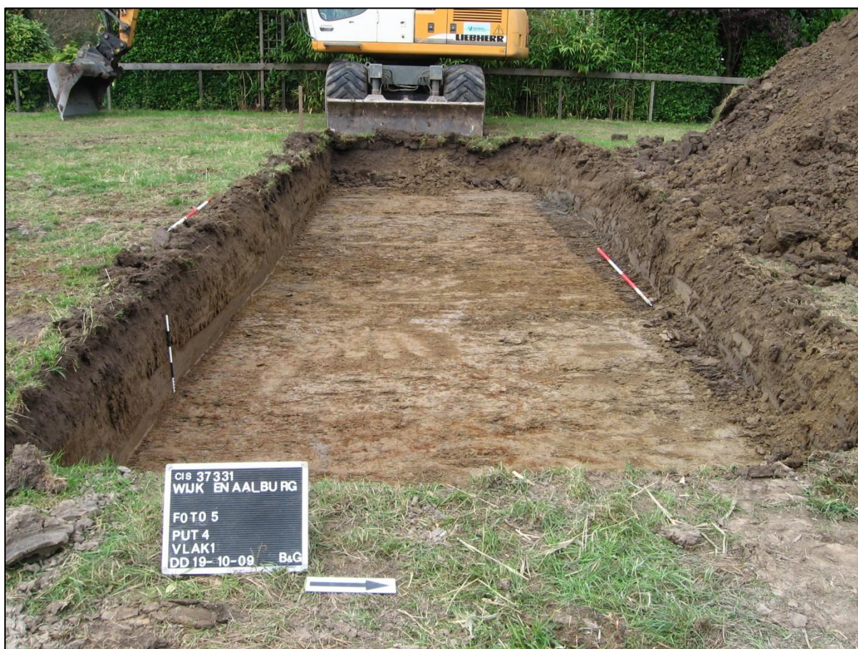
Figuur 3: Werkput 4, de bouwput van het woonhuis.
