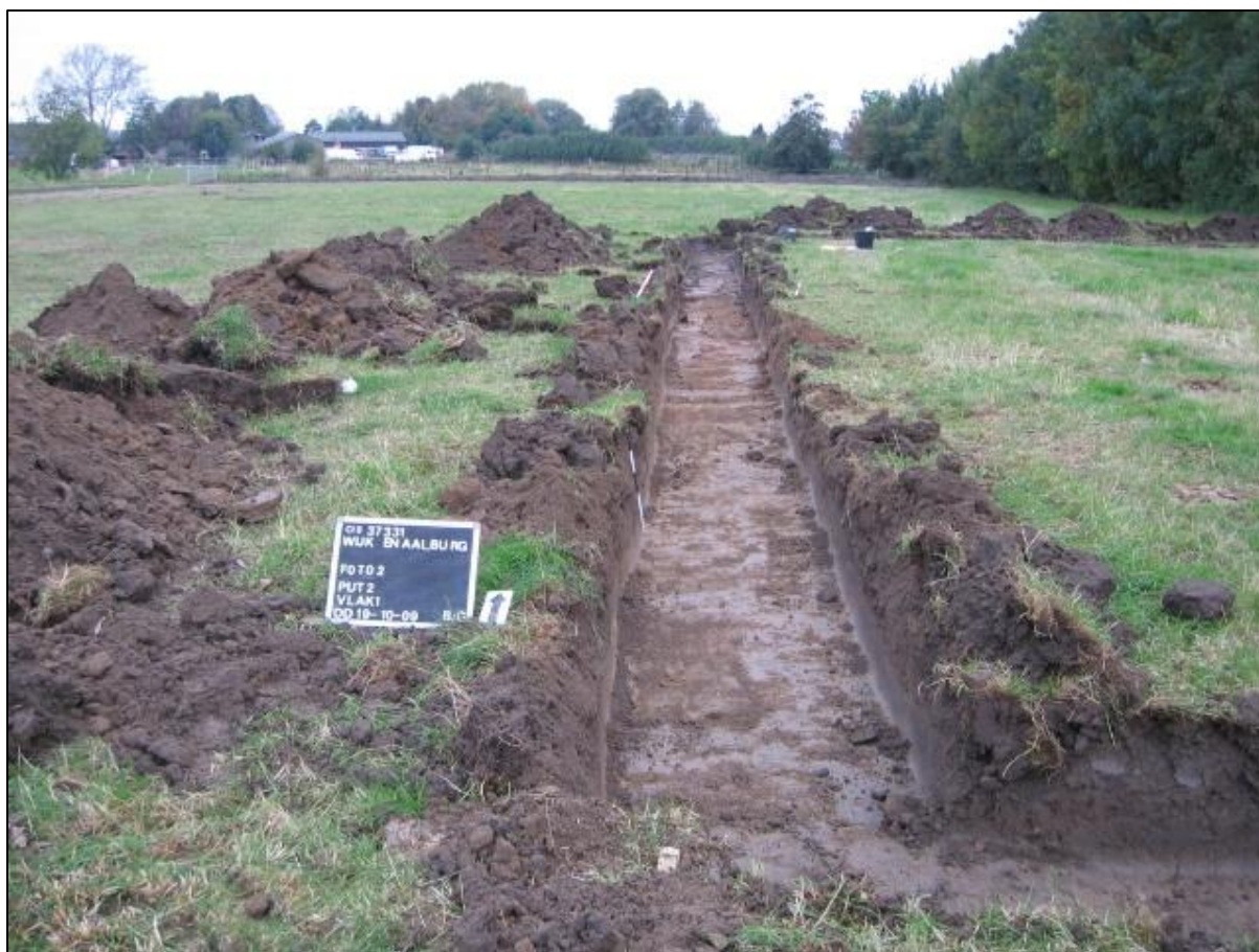
Figuur 2: Werkput 2, een funderings sleuf voor de bedrijfshal.
